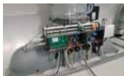
3 Caisson d'extraction avec organe de réglage, dispositif de mesure et de détection
