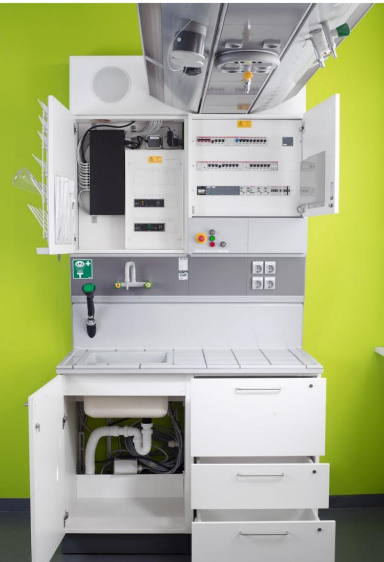
Die Anschlusszelle ist die zentrale Schnittstelle von allen bauseitigen Installationen zu den Deckenversorgungssystemen. Hier befinden sich u. a. die Übergabestellen für Gas (Gassicherheitsventile), Wasser, Strom (Elektro-Unterverteilung) und Multimedia (EDV-Schalter).
